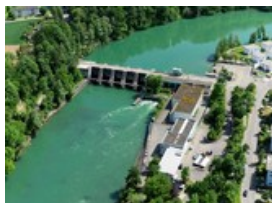
Kraftwerk Bremgarten-Zufikon der AEW Energie AG
